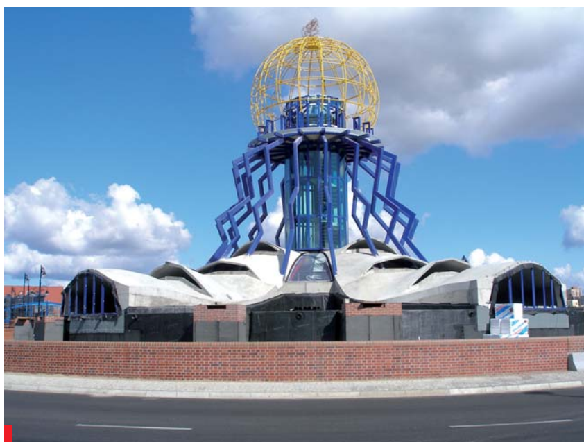
Betonowe łupiny jeszcze przed zaizolowaniem
