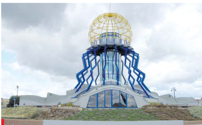
Gotowa hydroizolacja wyglądała estetycznie, niestety wskutek działań innych wykonawców — stanu takiego nie udało się zachować
