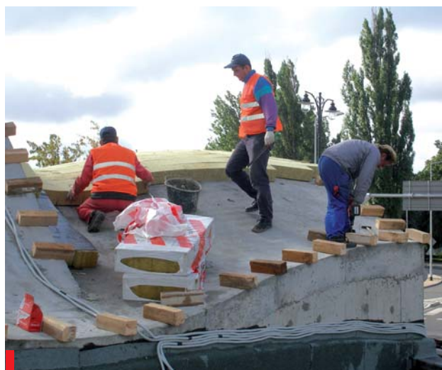
Przygotowanie łupin do krycia. Widać klocki drewna, na których zostanie ułożona płyta OSB
