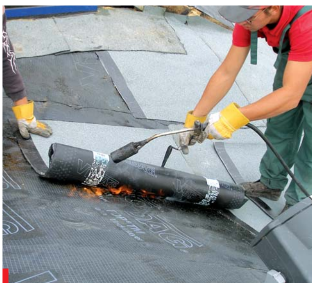
Zgrzewanie wierzchniej warstwy hydroizolacji
