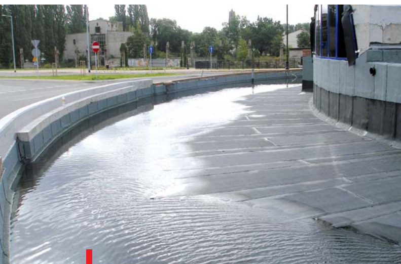
W niecce docelowo znaleźć się mają rośliny. Po zakończeniu prac aura poddała to miejsce próbie wodnej — test wypadł pomyślnie
