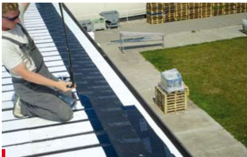
Na pasie nadrynnowym zastosowano papę samoprzylepną Vedatop SU
