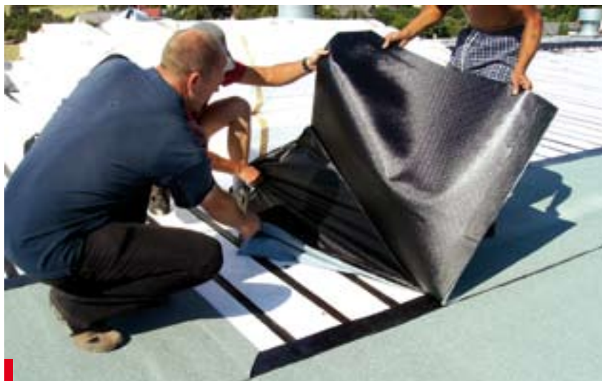
W niektórych miejscach dzięki upałowi papę można było układać bez używania palnika
