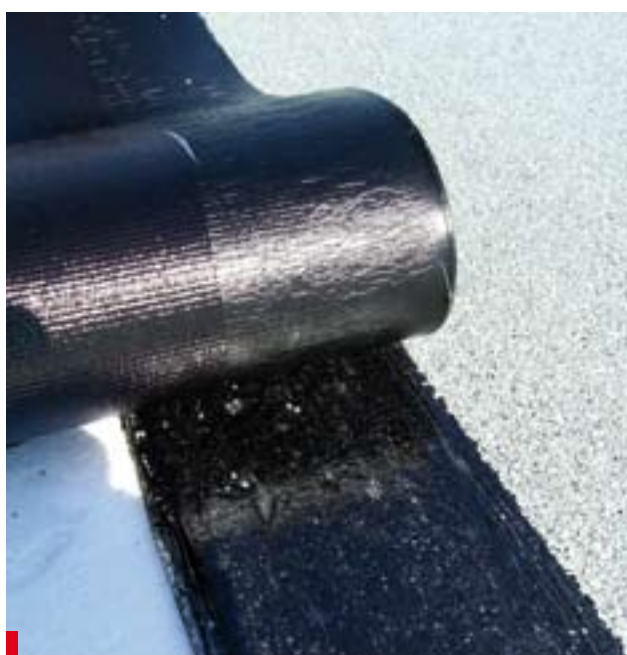
Zakład papy ma 10 cm szerokości, z czego 2 cm to pasek samoprzylepny, a 8 cm zgrzewalny
