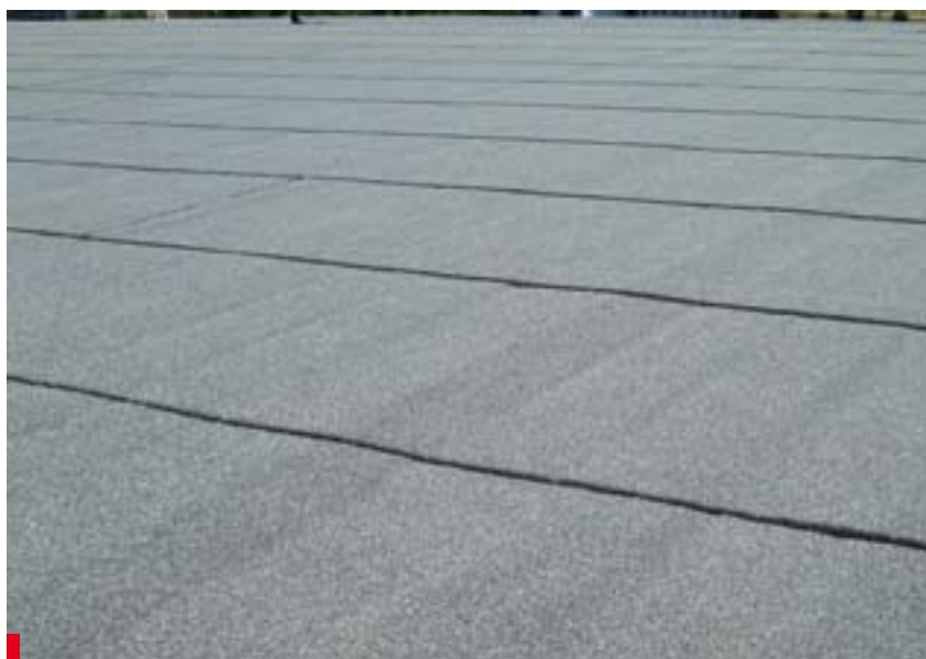
Ułożona papa dodatkowo usztywniła wiotki dach
