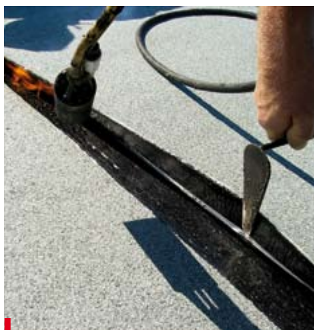
Wstępne zaklejenie samoprzylepnego zakładu zabezpiecza styropian przed płomieniem palnika
