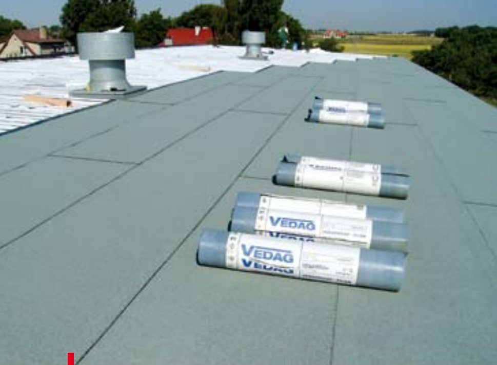
Pracownicy firmy wykonawczej docenili zalety technologii samoprzylepnej
