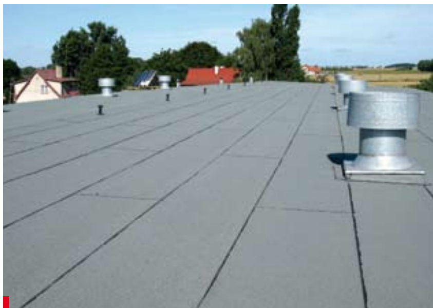
Nowy, szczelny dach, zadowolony inwestor...
