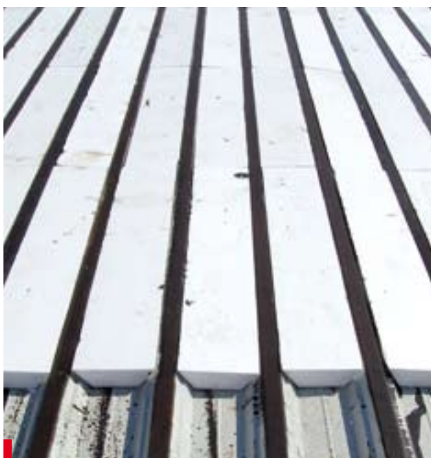
Styropianowe kształtki wklejone w blachę trapezową
