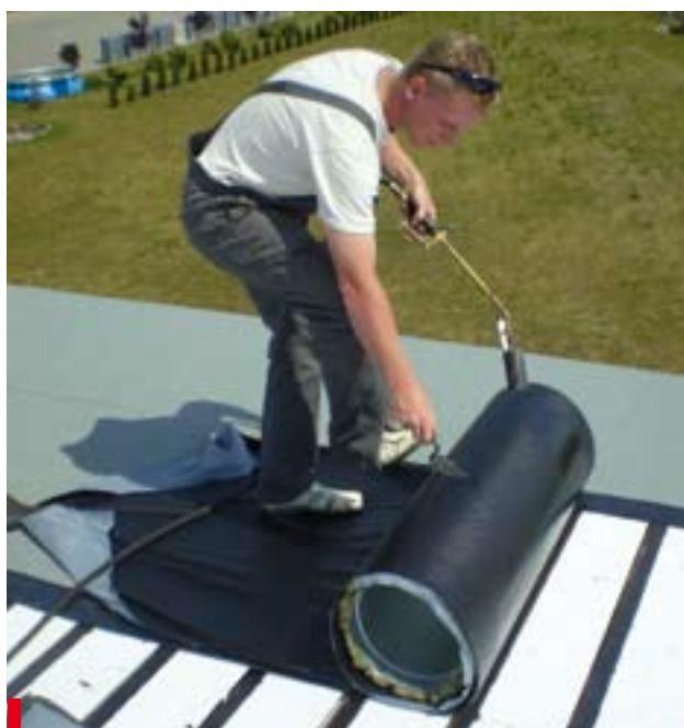
Dzięki podgrzewaniu papy na bębnie płomień palnika znajduje się z dala od styropianu
